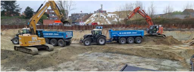
Hector Van Moer & Zonen is gespecialiseerd in grond- en afbraakwerken en werkt momenteel aan diverse projecten, waaronder deze bouwwerf in Hoboken.
